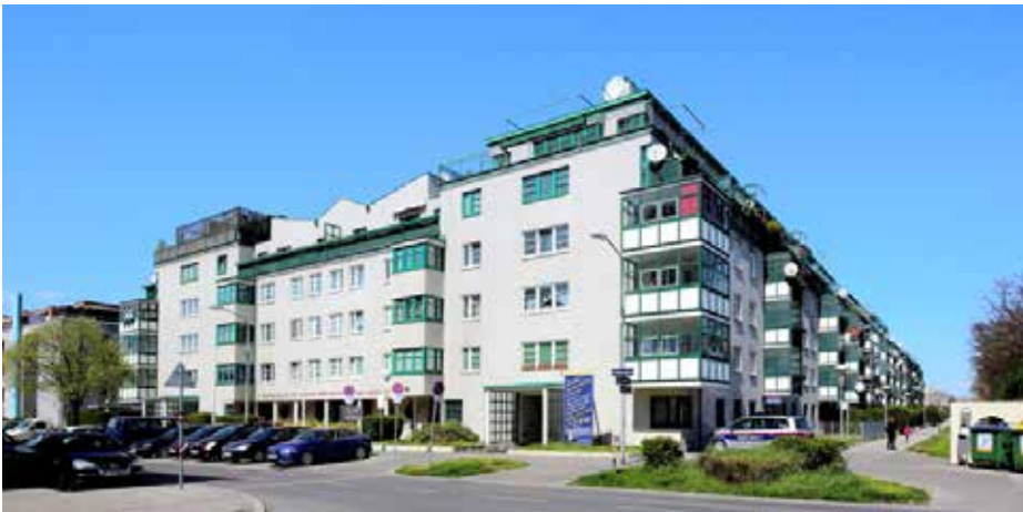
Ein 1995 nach Plänen von Viktor Hufnagl fertiggestellter Gemeindebau im Wiener Bezirk Floridsdorf – © Bwag/Wikimedia
